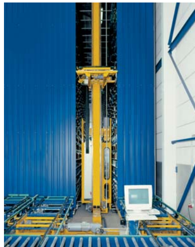
RBG nach Einlagerungsvorgang in der A-Zone des Automatischen Kleinteilelagers
